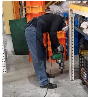
新設した倉庫にあるパレットラックの固定を安全委員会で実施しました。写真はアンカーボルト用の穴あけ作業の様子です。
